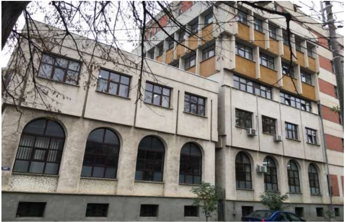
Foto.7 Fatadă Principală Corp SE
