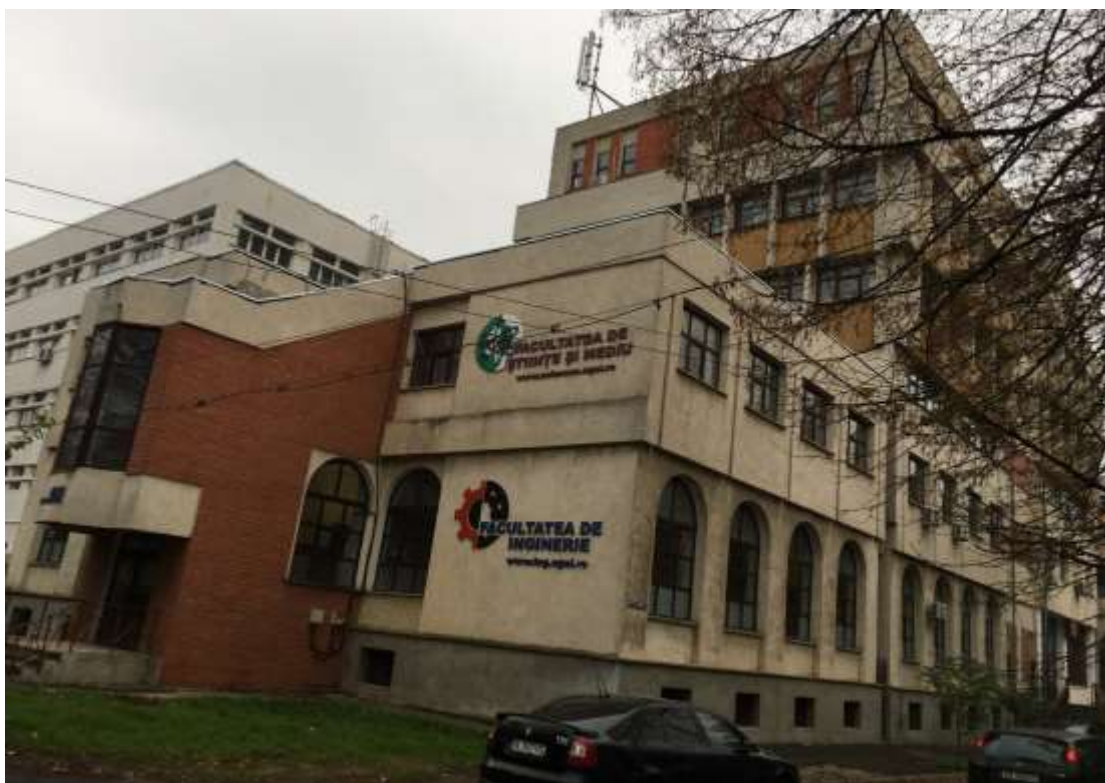
Foto.7 Fatadă Principală Corp SE
