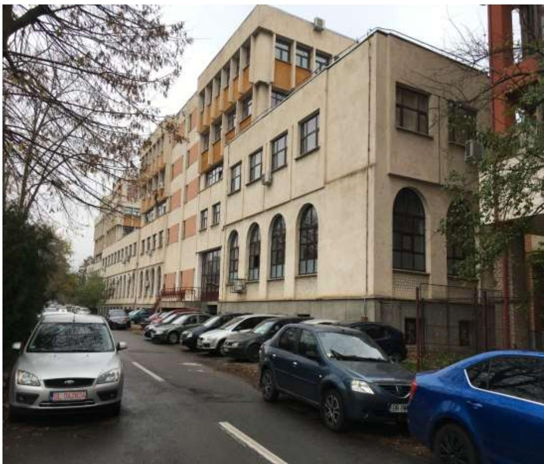
Foto.3 Fatadă secundară Corp SA-SE
